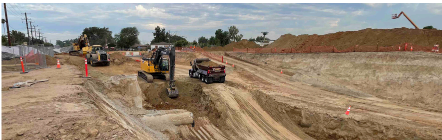
Las cuadrillas excavando tierra para bajar Jurupa Road al oeste del puente Van Buren Boulevard. Esta tierra se transportará para rellenar el área del pozo húmedo de la estación de bombeo de aguas pluviales al este de Van Buren Boulevard en Felspar Street.
