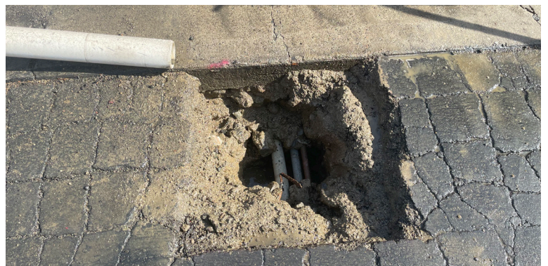
Las cuadrillas trabajando en la ubicación de líneas de servicios públicos.
