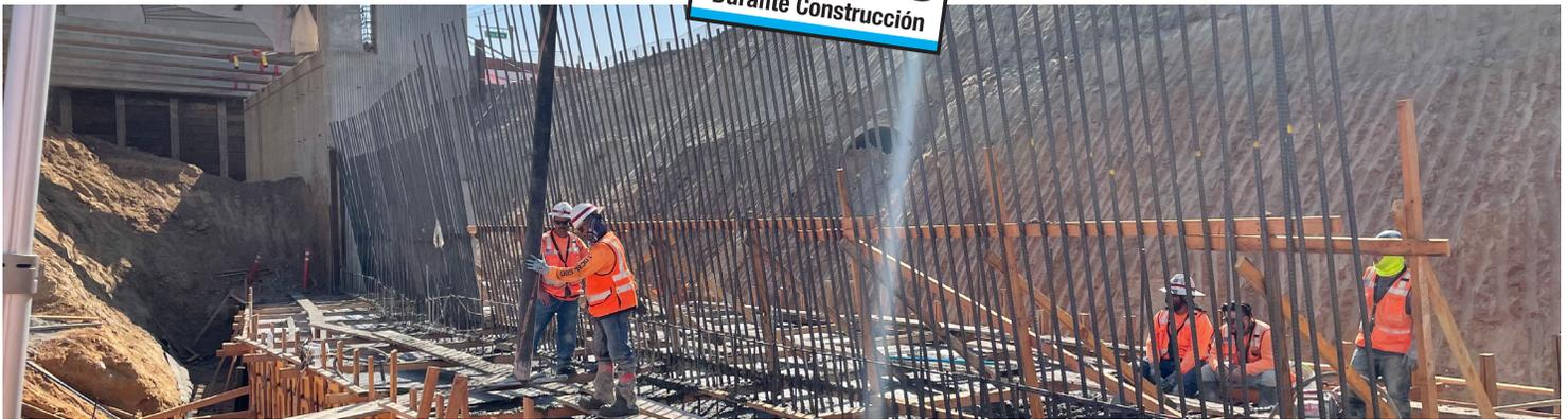
Las cuadrillas colocando hormigón para el sistema de soporte del muro de contención donde se está construyendo el paso subterráneo en el lado oeste de Jurupa Road.
